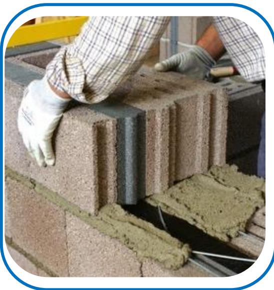
Murature termoisolanti
