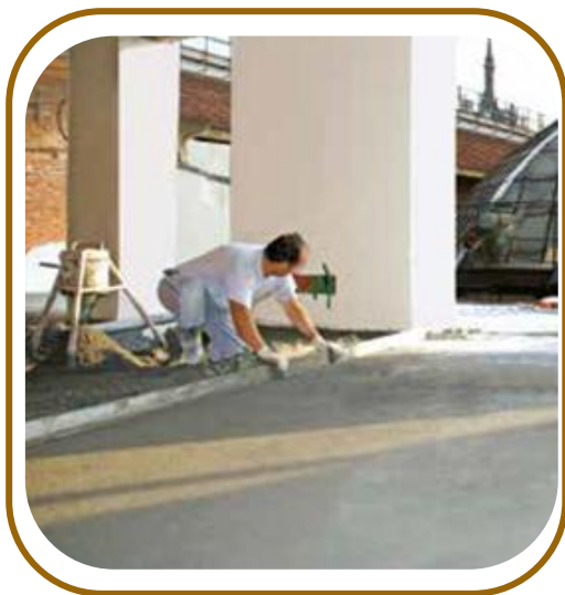
Sottofondi isolanti
